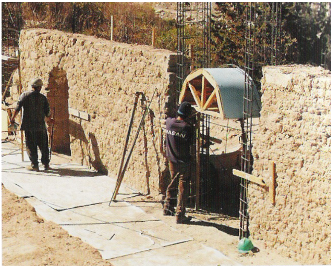
Figura 4. Muro de albañilería de adobe, fachada sur, 2005
