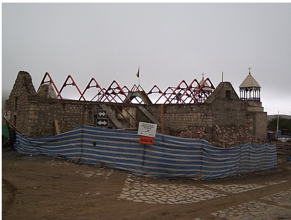
Figura 5. Vista obra desde el Nor-orient. Se aprecian estructuras metálicas de cubierta introducidas
