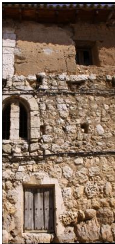
Figura 4. Vista de la composición del muro.
