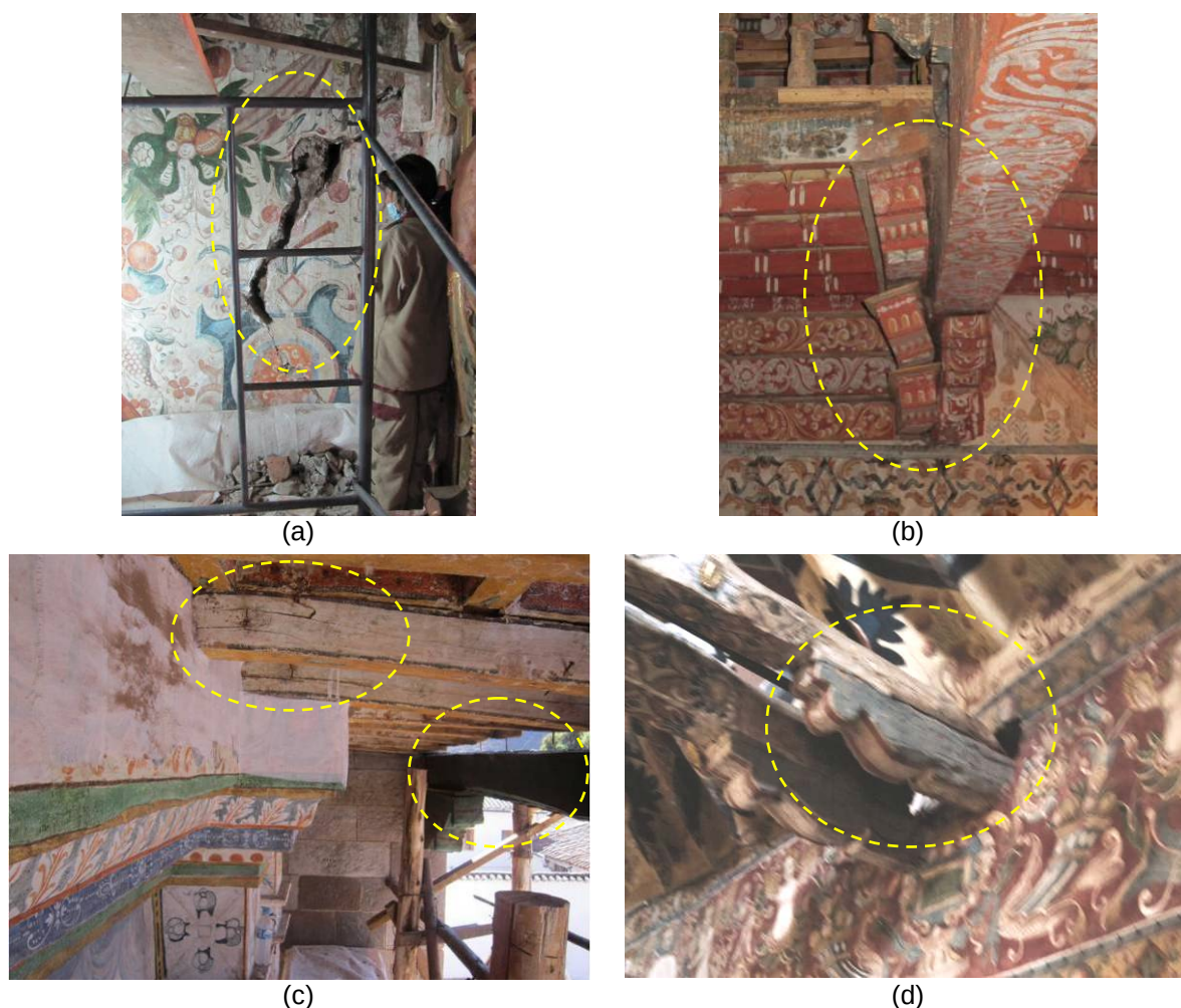
Figura 3. Patologías estructurales más evidentes en la iglesia: (a) grieta ubicada en la parte superior del arco triunfal; (b) deformación y desacople de canes que son parte del sistema de piso del coro; (c) tensor de madera apolillado; (d) viga aislada del sistema estructural y can fracturado en la fachada
