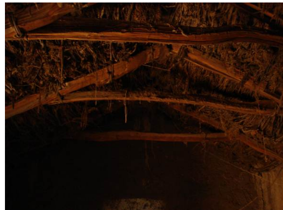
Figuras 2. Estructura de un techo en Susques con sus tijeras y alfajías (Fotografía propia)
