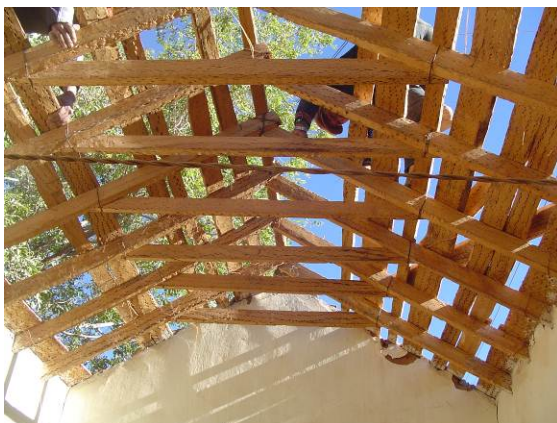
Figuras 2. Estructura de un techo en Susques con sus tijeras y alfajías (Fotografía propia)
