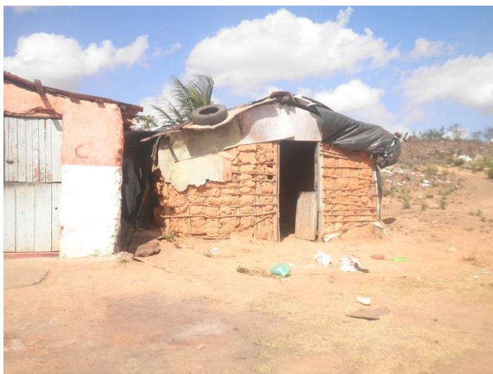
Figura 2 - Construção em taipa de mão ou pau-a-pique
