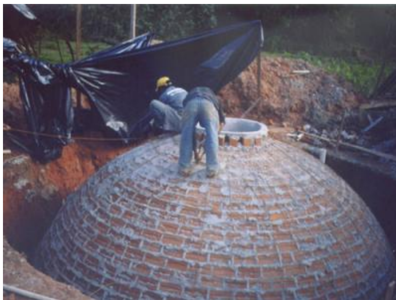
Figura 2. Biodigestor em construção no Haiti ( www.oia.org.br/new/biosistemas_integrados.asp )
