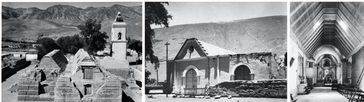
Figura 3. Situación de la iglesia luego del sismo de 1949, fachadas posterior y principal, e interior de la nave sur poniente. (créditos: Montandon, 1949 (izquierda); Benavides, 1950)
