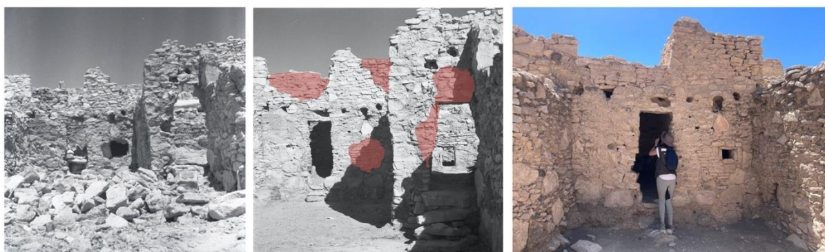
Figura 2. Representación de la situación anterior, la intervención efectuada (en color) y la situación actual, de los muros de un recinto (créditos: Montandon, 1949,1951; Valdivia, 2022)
