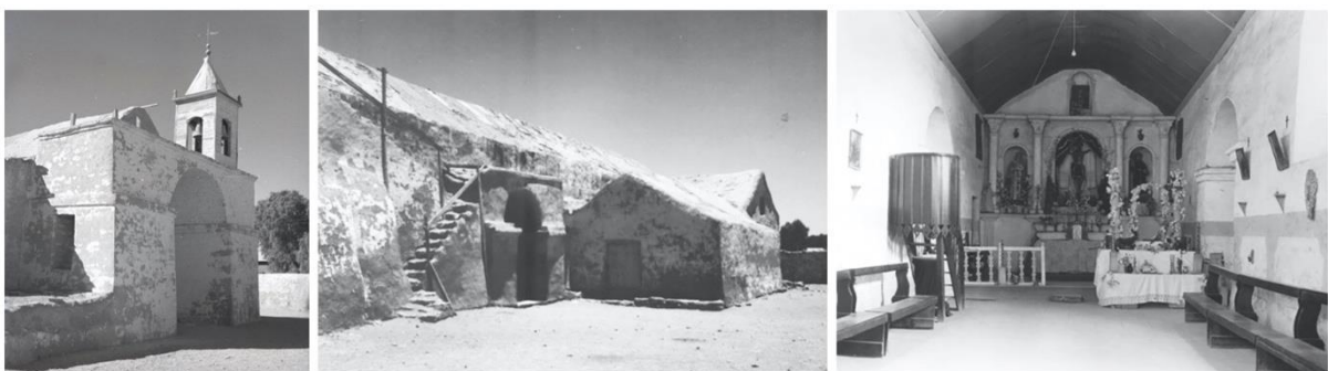
Figura 6. Muros y cubierta de la iglesia con pérdida de revoque. Interior de la nave, con lienzo en el cielo y piso de cemento (créditos: Montandon, c.1950 (izquierda); Benavides, c.1951)
