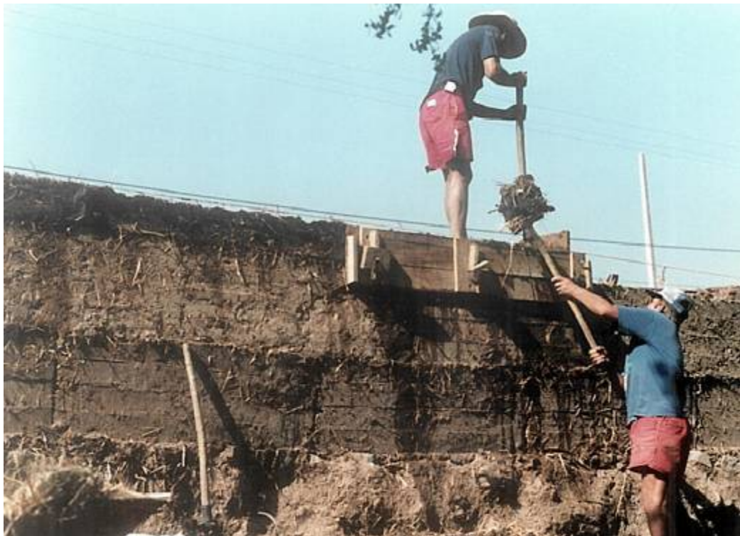
Figura 2. Fabricación de tapial, Enero 1992, Comuna de La Florida, Chile. Foto: H.Pereira Existen testimonios acerca de la utilización de la tierra en las construcciones agrícolas,
