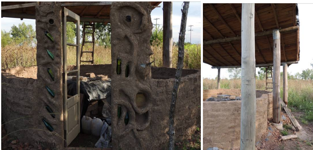
Figura 7. Ingreso a nueva vivienda
