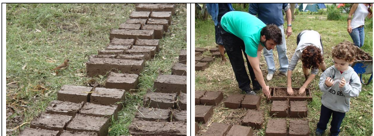
Figura 9. Fabricación de adobes
