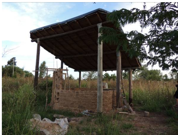
Figura 5. Vivienda en construcción
