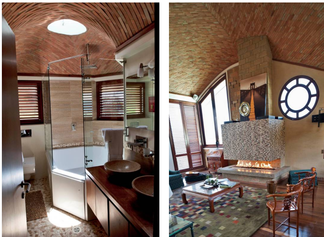
Figura 9– Espacialidad de Casa Supitina del baño y el estudio, construido con panetes de cal y arena. Fotografía: Andrés Bermúdez
