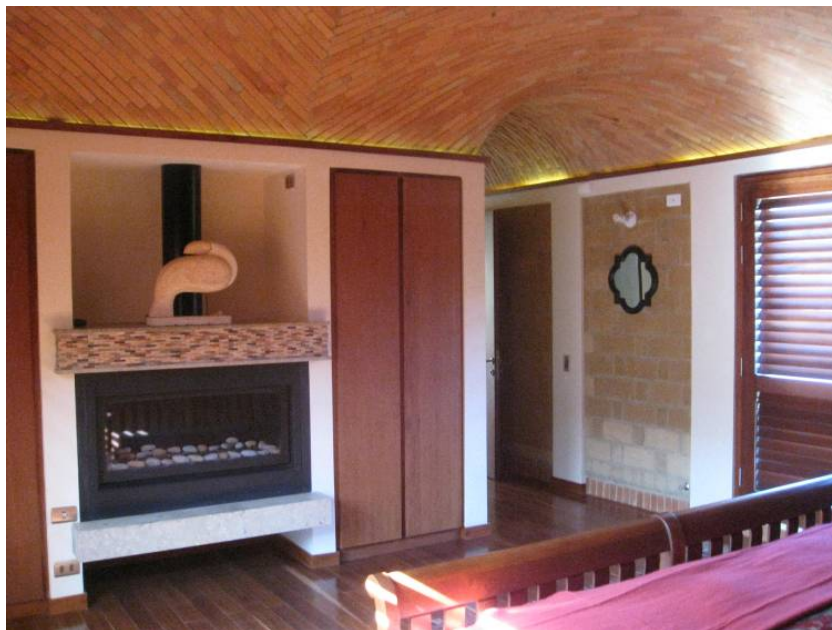
Figura 8 – Casa Supitina – Dormitório com BTC y bóvedas. Fotografía: Andrés Bermúdez
