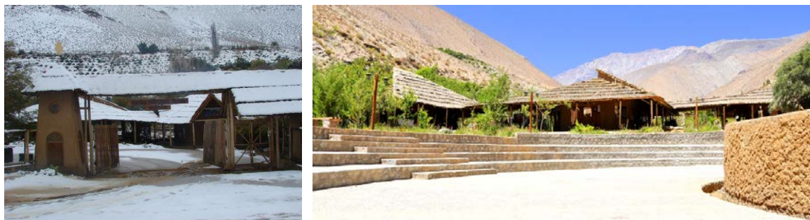
Figura 1 – Acceso y plazoleta interior del Pueblito Artesanal de Horcón, con nieve en el invierno (VII/2011) y seco en el verano (2013). Fotos: www.puebloartesanaldehorcon.cl
