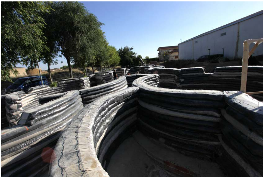
Figura 4. Imagen del proceso constructivo
