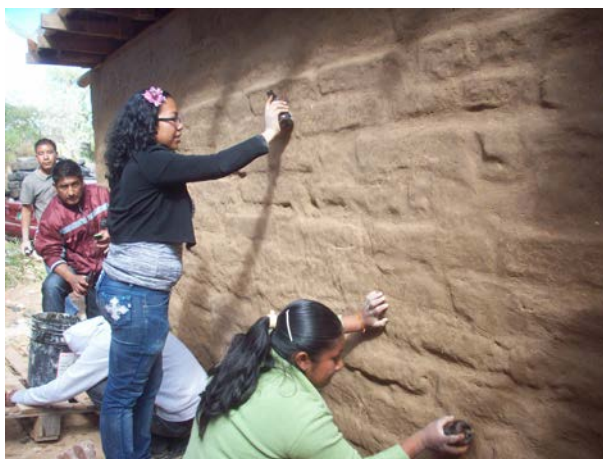
Acabado de revoque realizado por alumnos del Tecnológico de Teposcolula, Oaxaca, México
