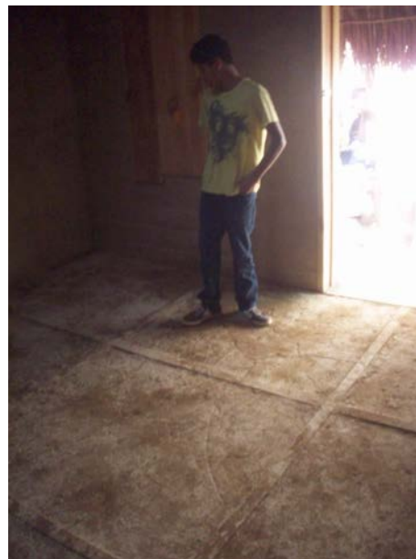
Primera capa de piso
