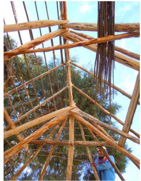
Cubierta en proceso de construcción
