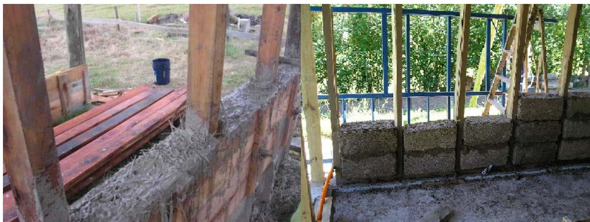
Figura 1 – Comparación entre tierra alivianada y BTA
