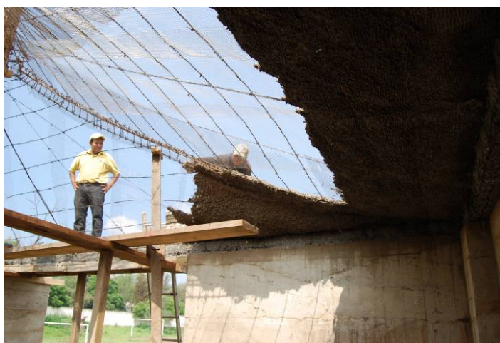
Figura 5. La primera capa de hormigón de tierra sobre la malla metálica del techo (Foto: L. Guerrero)
