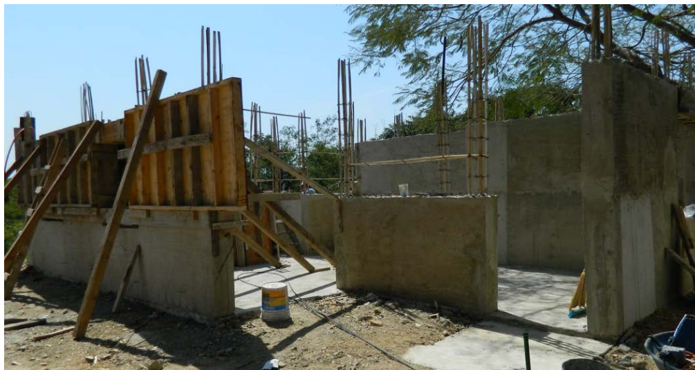
Figura 5: Fachada principal, proceso de cimbrado. En primer plano los castillos de reglillas de bambú. Foto: Aranda, Marzo 2013.
