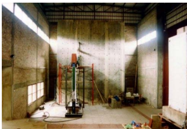
Figura 3. Losa de carga y muro reactivo
