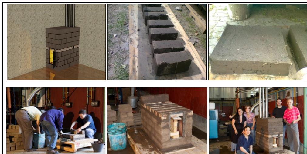
Figura 1: Proyecto de la estufa y fases de construcción. Fabricación de adobes, primera hilada, ladrillos refractarios y estufa finalizada. Laboratorio en INTI Energía (noviembre/diciembre 2012). Imágenes: elaboración propia.
