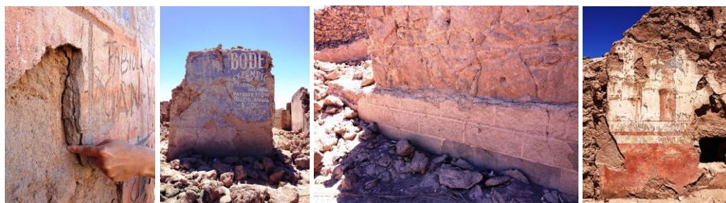
Figura 7. Diversas manifestaciones constructivas a escala de acabados y terminaciones uso del costrón en Pampa Unión. Fuente: registro propio, Pampa Unión 2013.
