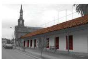
Techumbres continuas y paralelas a la calle
