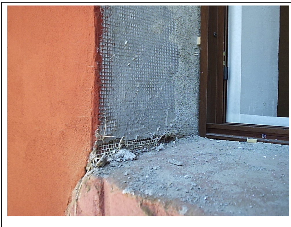
Figura 6. Malla de fibra de vidrio con propasta E
