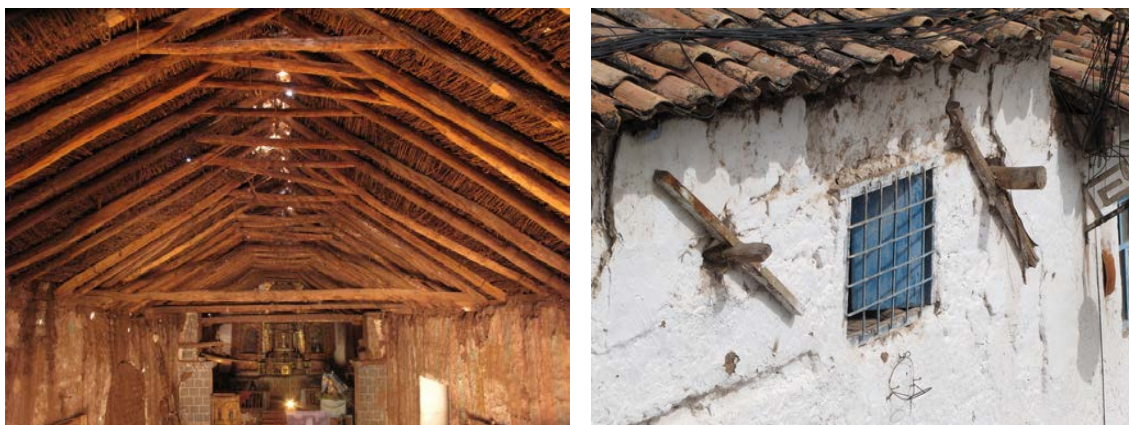
Figura 4 - Izquierda: tirantes en la iglesia de Kuño Tambo, uno de los edificios prototipo del proyecto SRP (Foto Claudia Cancino, 2010) Derecha: Vista exterior de conexiones de tirantes en Cuzco (Foto Sara Lardinois, 2012 © J. Paul Getty Trust).
