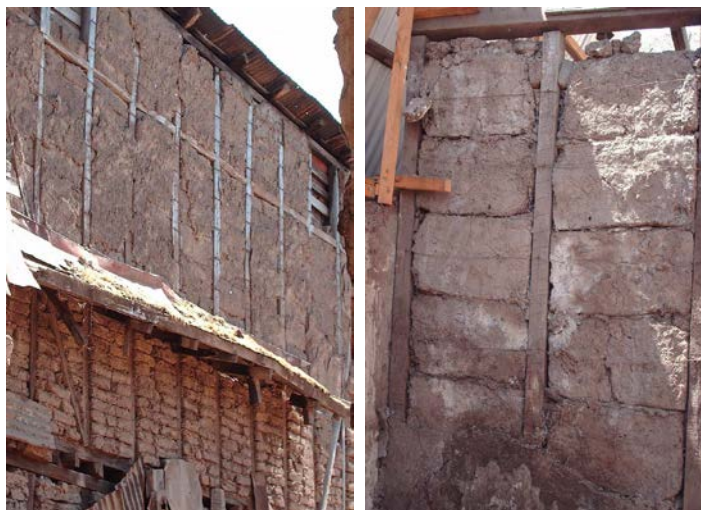
Figura 4. Detalle del sistema mixto madera-tierra cuya debilidad son las conexiones. (Créditos: Natalia Jorquera)
