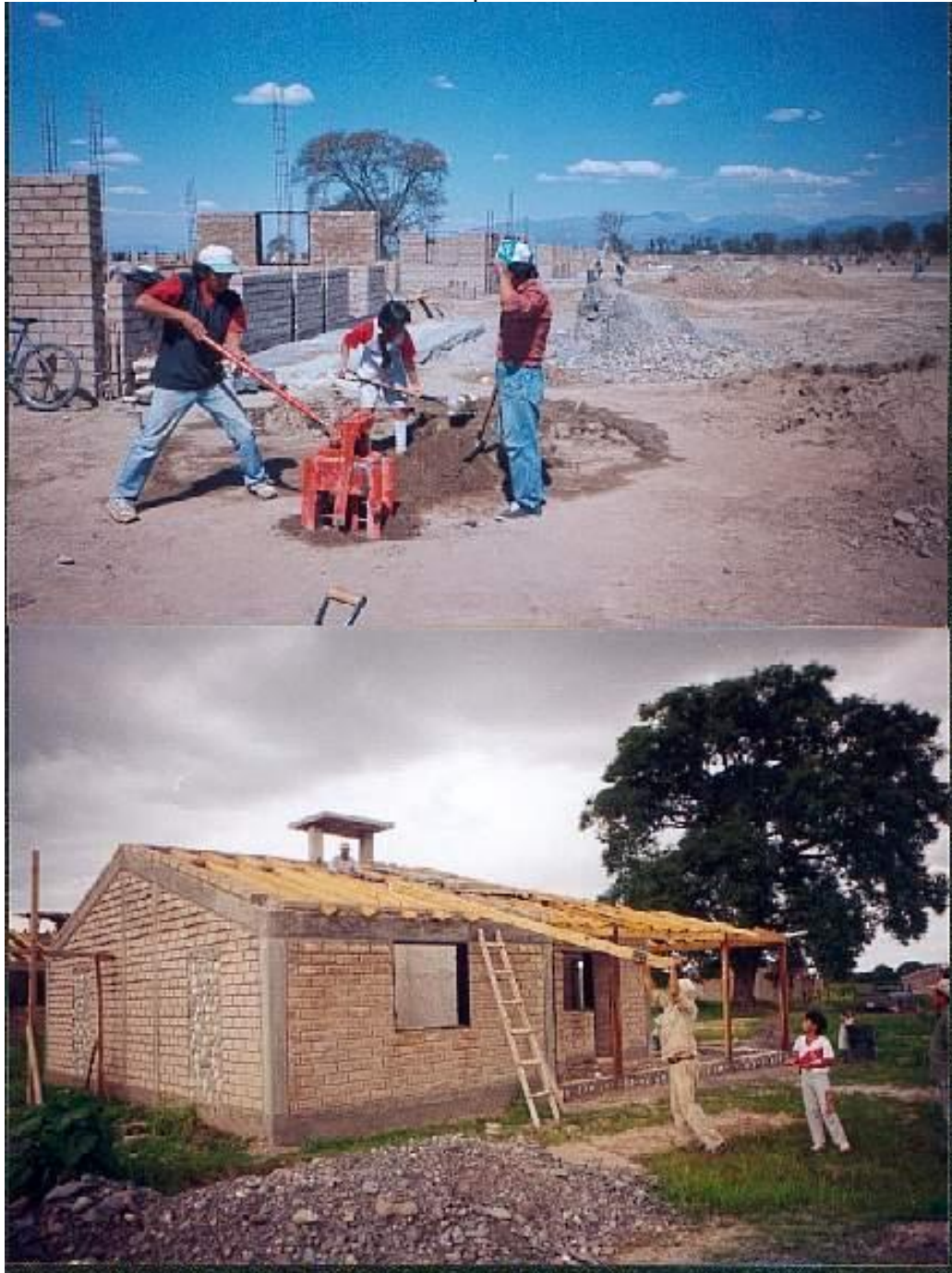
Fig. 1: Fabricación de bloques de suelo cemento y armado de estructura de madera para cubierta (B° Ecosol – 1998)
