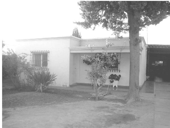
Fig.2. Vista de la vivienda de adobe
