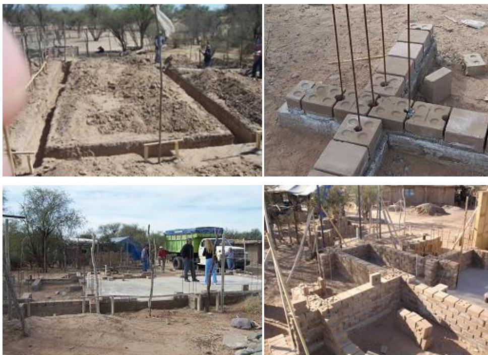
Fig 2 Imágenes del Proceso Constructivo
