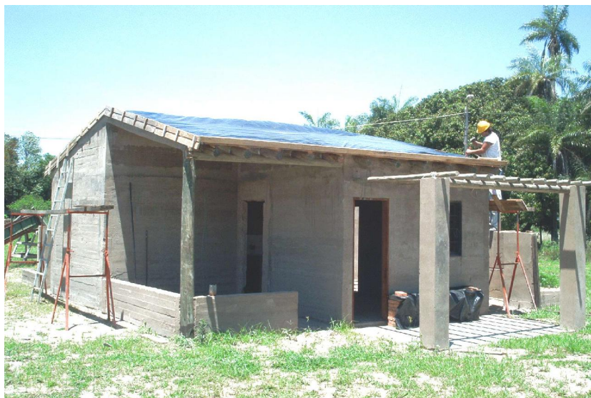
Fig. 4 – Prototipo de suelo-cemento en construcción
