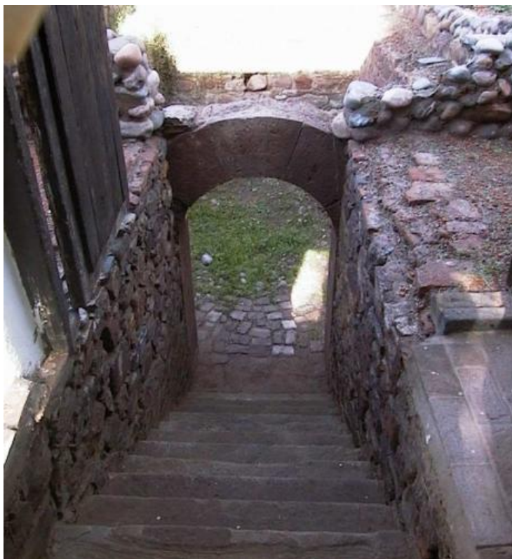
Acceso a la cava.
