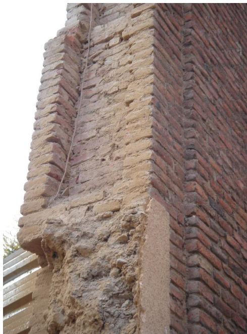
Imagen 4. Cajeadado de la obra de ladrillo para ejecutar la tapia de tierra trabada con la de ladrillo, que se puede ver en la demolición parcial de la tapia del convento de las Salesas.
