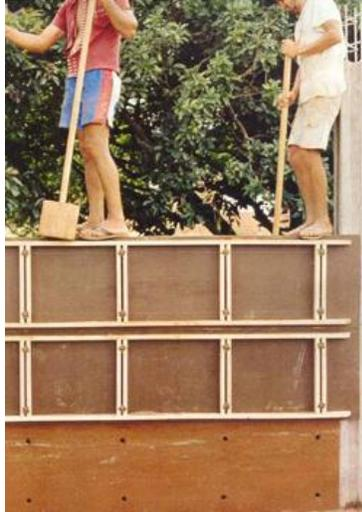
Figura 3 – Compactação do solo-cimento nos moldes
