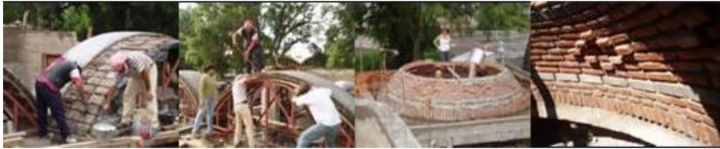
(Fig. 3) Construcción Techos de bóvedas y cúpulas
