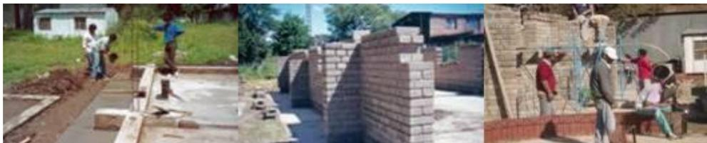
(Fig. 5) Elevación muros de BTC y BaTc-I
