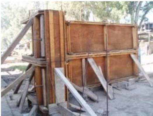
(Fig. 2) Ensamblado de moldes
