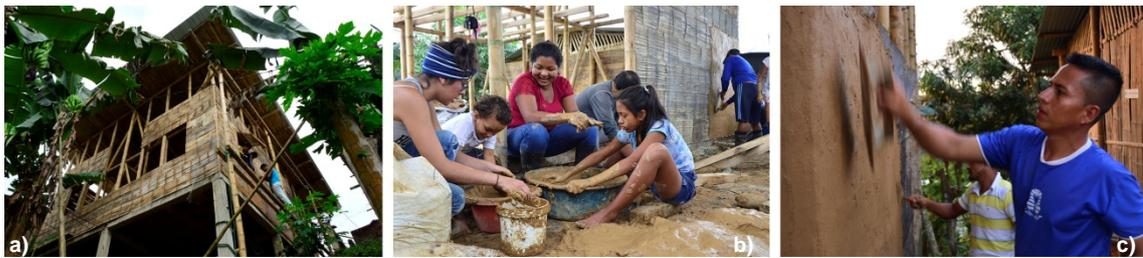
Figura 5. Construcción en sitio: a) colocación de caña picada; b) mezcla de tierra; c) enlucido con tierra (acervo Ensusitio)
