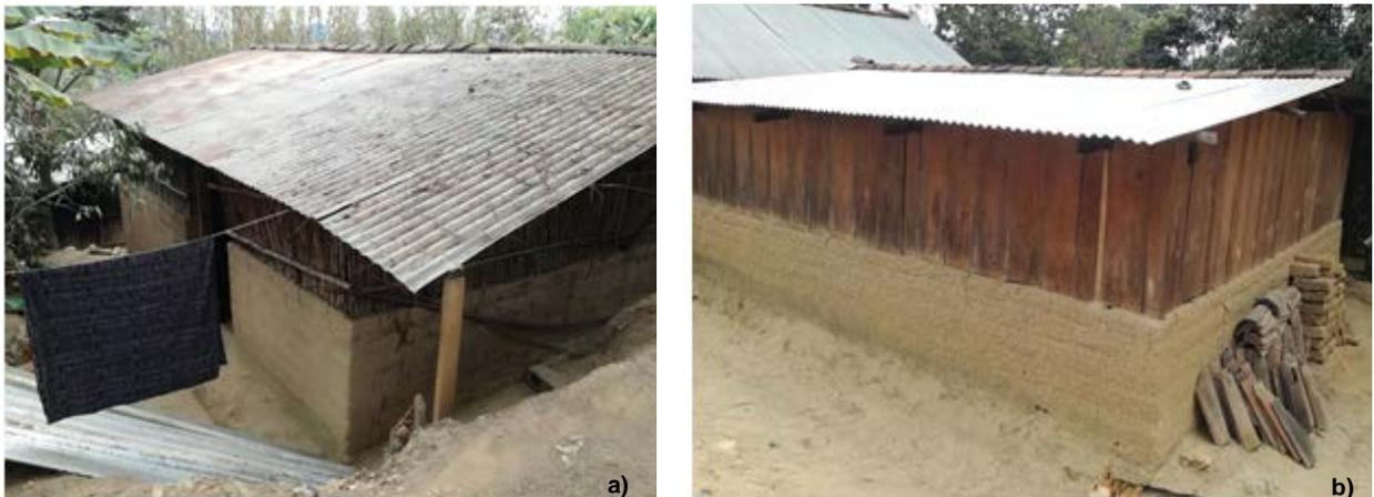
Figura 5. Vivienda con medios muros: a) finalizado con varillas de caña de castilla; b) finalizado con madera (crédito: E. Mayor, 2017)
