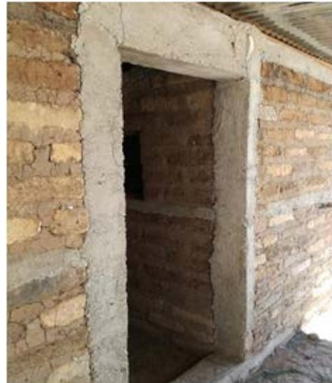
Figura 4. Viviendas con muros con refuerzos de concreto armado (crédito: E. Mayor, 2017)
