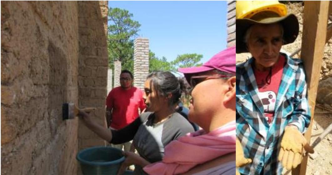
Figura 3. Preparación de la superficie de adobe y material de puente entre la pared y la capa nivel
