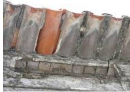
Figura 8. Beiral com projecção de tijolo
