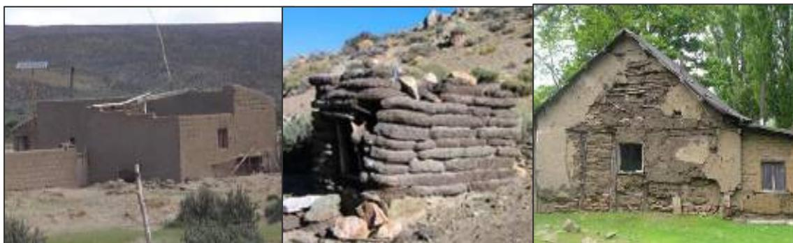
Fig. 2 – Mampostería de adobe, mampostería de champa y entramado de ramas y barro, con torta de barro y cubierta de chapa de zinc (Créditos: Mele, De Benito, Garzón; 2004-2007)
