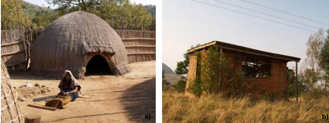
Fig.1 a) Palhota tradicional da Swazilândia; b) Construção de pau-a-pique entre a fronteira de Moçambique e a Swazilândia, preenchida com barro seco ao sol (créditos: Margarida Donas Botto, 2009)
