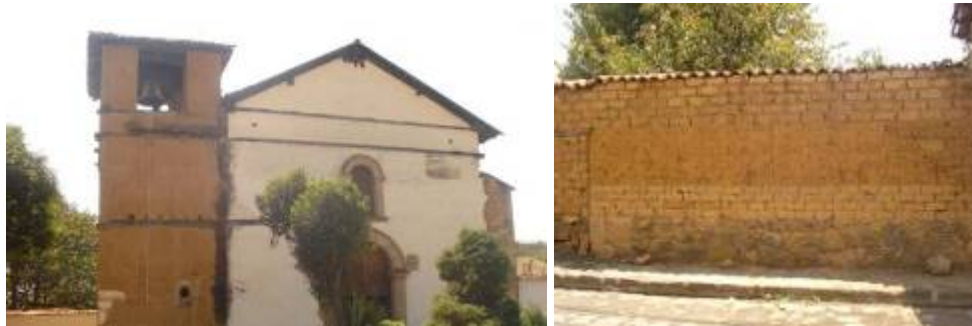
Figura 8 - Campanario Iglesia Santiago de Tupátaro, Michoacán, México; Templo cuyo artesanado de madera se encuentra decorado con pasajes bíblicos.
