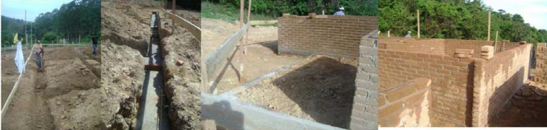
Figura 1 – A Casa de Apoio do Projeto CRESCER começa a tomar forma: a locação, a fundação (sapata corrida em concreto) e a alvenaria de BTC (Crédito: Rosana Parisi, setembro/outubro de 2008)
