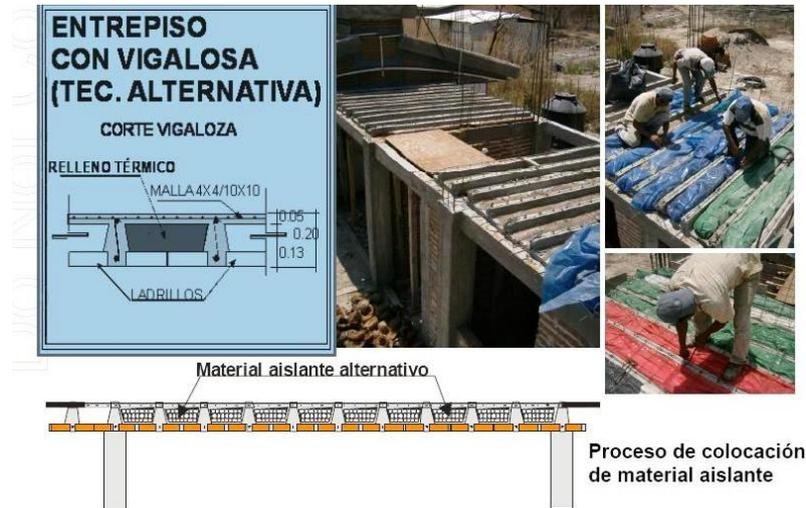
Figura 3 – Esquema da laje leve mexicana que emprega como enchimento leve casca de coco, serragem, ou resíduo de PET. Protótipo instalado no campus da Universidad Autónoma de Chiapas, México (Crédito: Gabriel Castañeda, 2008)
