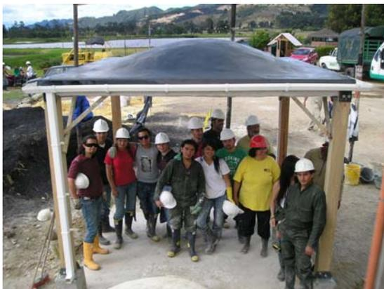
Figura 6. Domo Caña, construido con estructuras de madera, impermeabilizado con canales y bajadas de agua lluvia. (Crédito: Lucia Esperanza Garzón, 2009).
