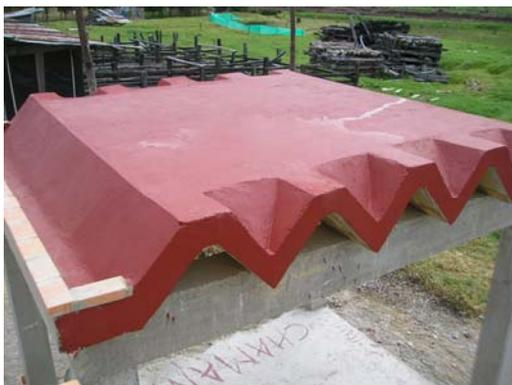
**Figura 4** – Prototipo de bovedillas construidas con bloque tierra cemento – BTC. Sistema innovador que funciona como entrepiso y como cubierta. Taller dirigido por la Arq. Clara Ángel (Colombia) (Crédito: Lucia Esperanza Garzón, 2009)
