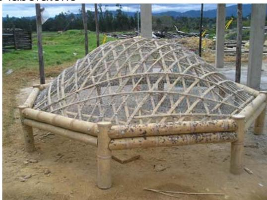
**Figura 5.** Prototipo de domo caña realizado en guadua, técnica desarrollada en Perú; transferencia del taller realizado por la Ing. Raquel Barrionuevo /Perú.
