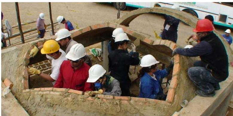
Figura 1 – Prototipo de bóveda con ladrillo recostado dirigida por Ramón Aguirre, México (Crédito: Lucia Esperanza Garzón, 2009)
