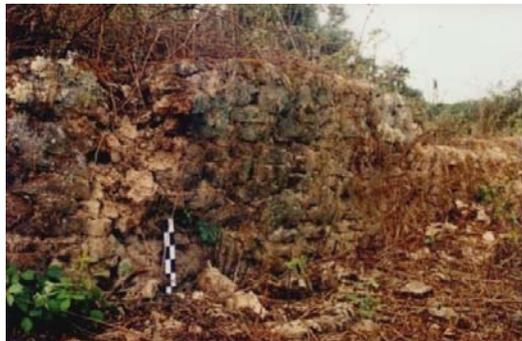
Fig. 3 – Parede em "alvenaria de pedaços de cortiça" na Herdade da Cascada, Montemor-o-Novo (Crédito: Rui Ferreira, 2000)
