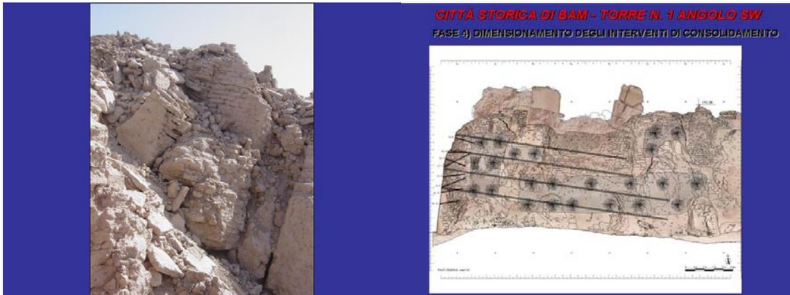
Fig. 5 – Vista del estado del daño en la torre y plan de perforaciones ortogonales e inclinadas, para refuerzos de fibra de vidrio. Ciudadela de Bam, Irán. (Crédito: Ing. Valter Santoro, 2008).
