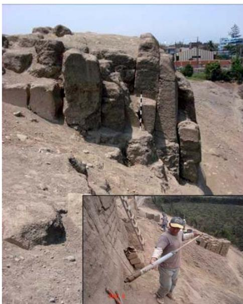
Fig. 3 – Muro de sostenimiento debilitado, que se inyecta para multiplicar su resistencia frente a los empujes laterales del relleno. (Crédito: Mirna Soto, 2008).
