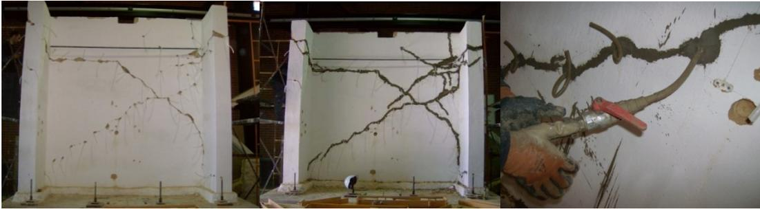
Fig. 15 – Mangueiras de injeção; Fig. 16 – Selagem das fissuras; Fig. 17 – Injeção da goma de cal hidráulica sob pressão (créditos: autores 2009).
