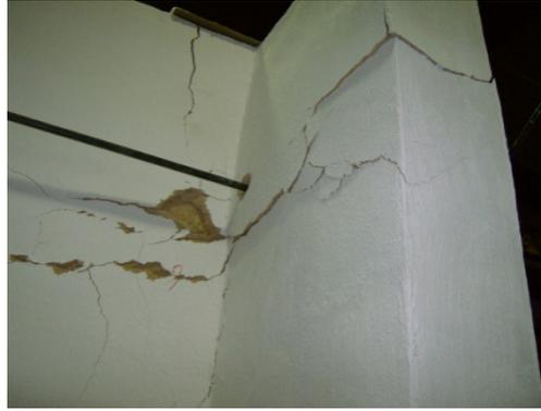
Fig. 3 – Danos observados na face interior da parede, junto ao apoio (créditos: autores 2009).
