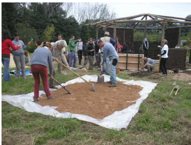
Figura 4: Mezclado en seco de suelo tamizado con cal para la fabricación de un tapial. Curso-taller con apoyo de ONG (SAHDES) con práctica intensiva en chacra El Arca, Luján, provincia de Buenos Aires. Participación de constructores, empleados, ingenieros, arquitectos (FAU-UNSj, San Juan).
