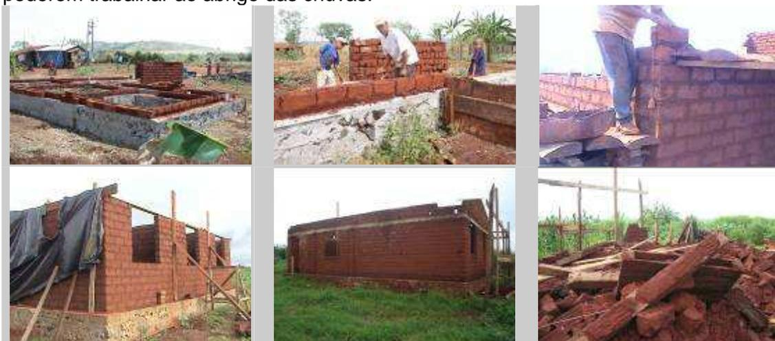
**Figura 7** – Etapas de construção da casa com paredes autoportantes de adobe e do desmoronamento de uma delas (acervo HABIS).
