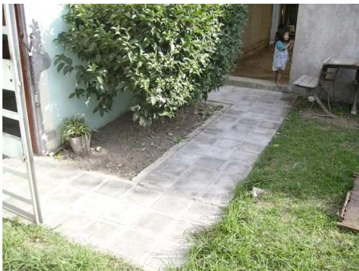
Figura 1: Piso exterior con baldosas CONICET en patio exterior del centro vecinal de Bancalari. Prototipo demostrativo en uso y evaluación desde 2007.
