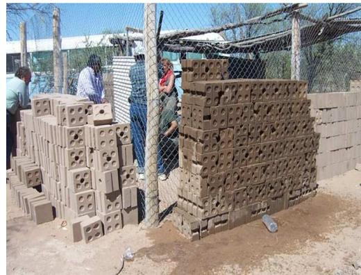
Fig.4 Irpha-Ram-Contrafuerte armado-Sistema Constructivo (créditos: Albarracín- Dubos 2010)
