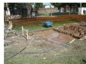
**4.1.1- Suelo:** Se procedió a secar los barros de excavación profundas para pilotes (mezclas de cota -2,00 m a -13,00m), siendo posteriormente triturados y tamizados. Se caracterizaron dichos barros identificando las variables y su incidencia en las propiedades de los especímenes, con el objetivo de lograr la mejor estabilización y los modos de ejecución.
